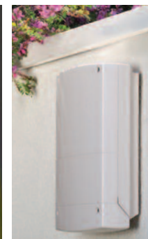
Coffret technique sans antenne visible
