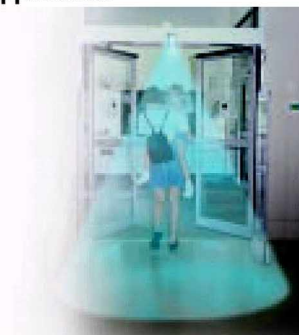
Lobes de détection en fonction de la position latérale de l'antenne hauteur de montage : 2,2 m
