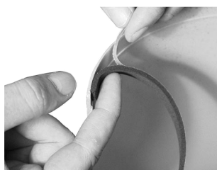
Installation der Dichtung
