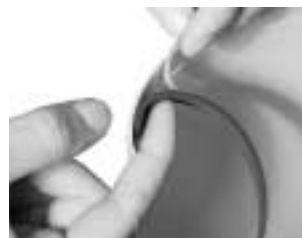
Installation der Dichtung
