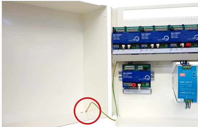
Afbeelding 18: PE-aansluiting
